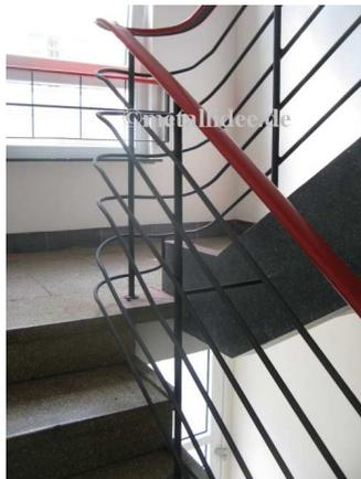
Demontage des alten Handlaufs und Montage von 45 lfdm. Rehau Mipolam Handlauf 40x8mm mit einer Endkappe, Farbe # 308 rot. An den 5 Brüstungsgeländer zur Straße den Einzelhandlauf ca. 8,5m wie vor demontieren und auch einen neuen Handlauf wie vor aufgezogen.
